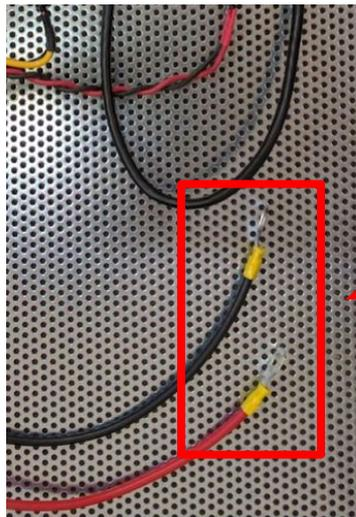
Dans le fond de l'armoire, un fil rouge et un fil noir équipés de cosses rondes pour la connexion de la batterie.
